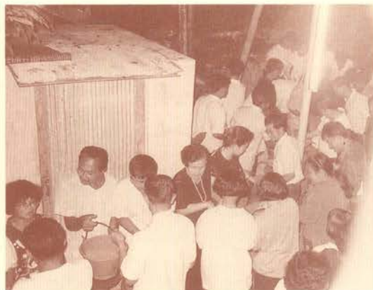
ช่วยกันขนทรายถมบ้นฝาซีเมนต์ ๑ ฟุต
